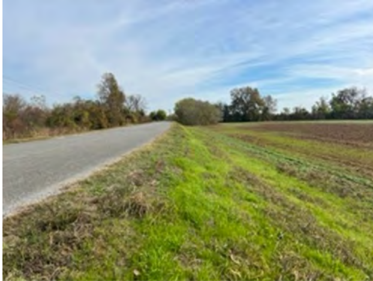
N. End looking east
